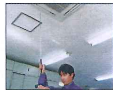
エアコンの噴出し口
