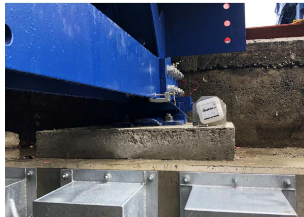
仮橋の挙動監視
