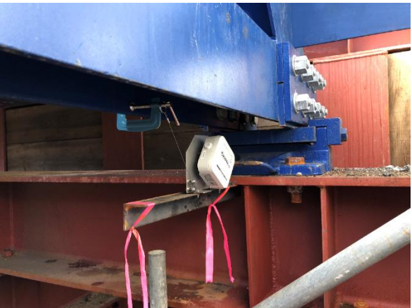
仮橋の挙動監視
