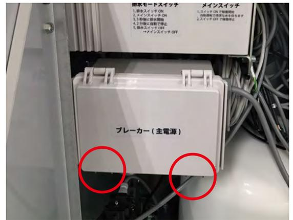
電源ボックス内のブレーカーをON(上側)後、金具を留めて電源ボックスのカバーを閉じる。
