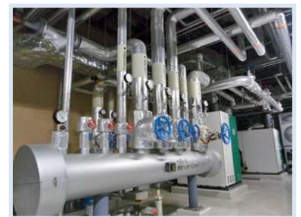
▲工場内ボイラー室
