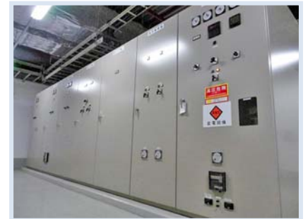
▲工場内電気室
