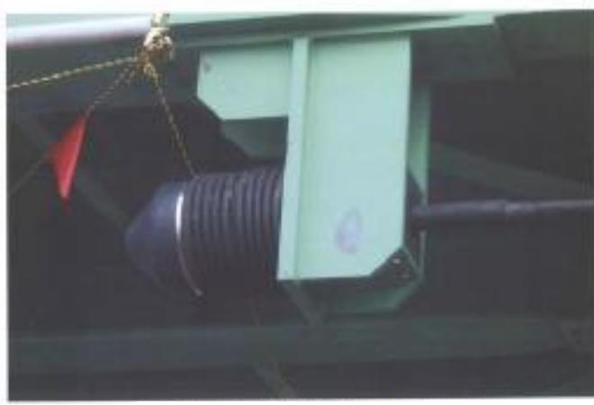
・落橋防止装置損傷状況
