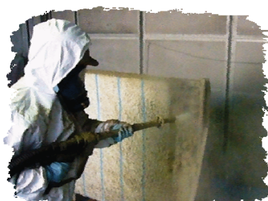
湿式アスベスト除去(ノンアス試験体)
