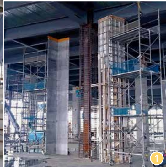
SRC独立柱施工状況 (トランスタワータイプ:L型2面自立移動式) ①
