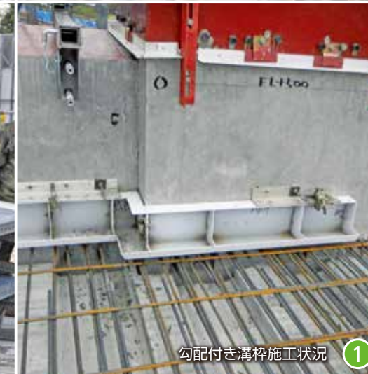
段差枠+グラウト型枠施工状況 ①
