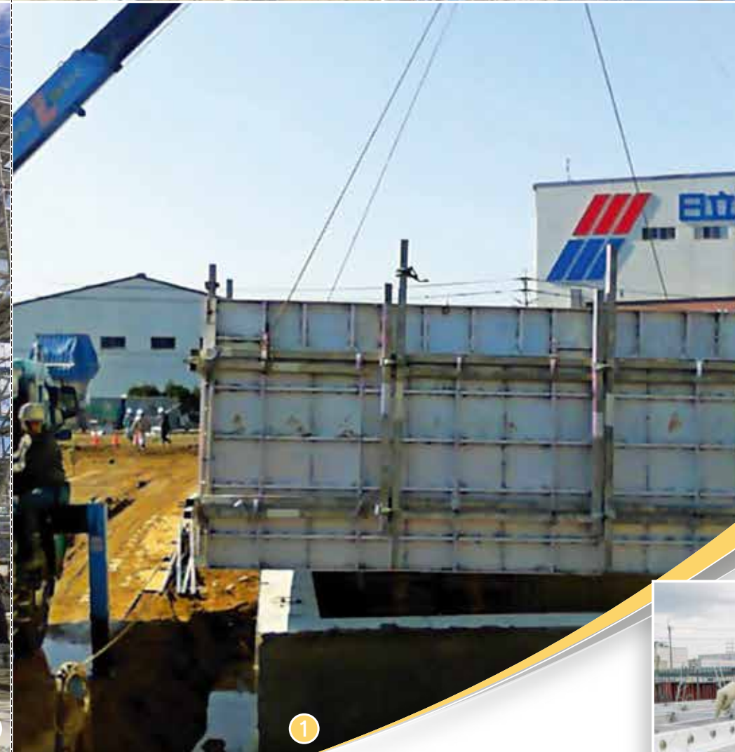
RC独立柱施工状況 (トランスタワータイプ:4面脱枠〜SET) ②
