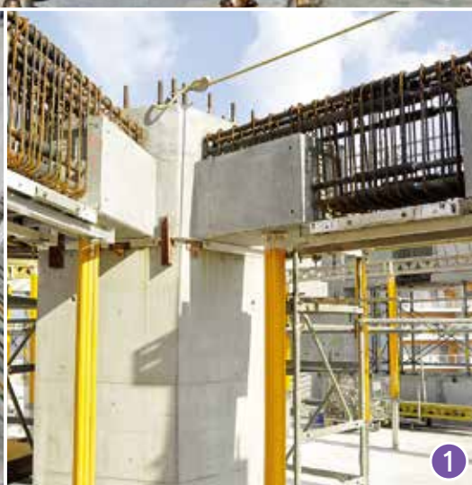
柱PC製作施工状況(トランスター:3面 自立移動式) ①
