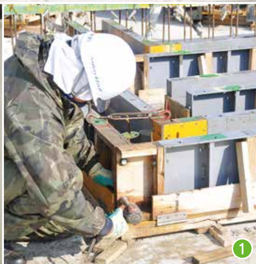
階段PC製作施工状況 ①
