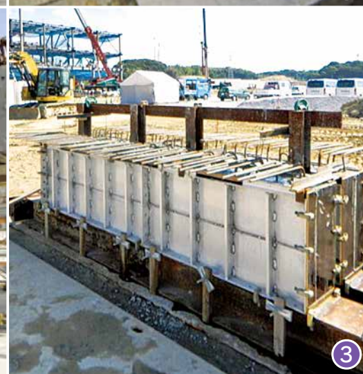
バルコニーPC製作施工状況 ③
