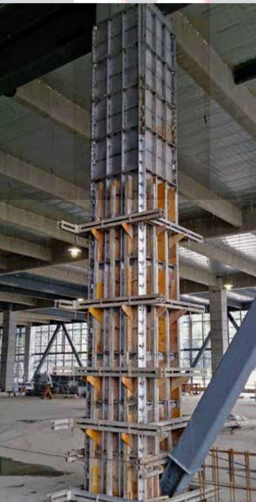
SRC独立柱施工状況 (トランスタワータイプ:L型2面自立移動式) ①
