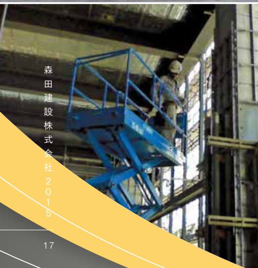
SRC独立柱施工状況 (トランスタワータイプ:L型2面自立移動式) ①
