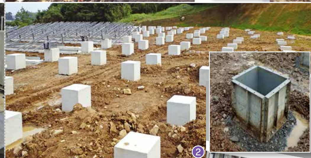
太陽光基礎施工状況 ②
