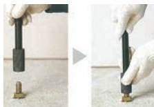
②アンカーの径に合わせてカップリングをセンターシャフトに取り付けてアンカーにセットする。
