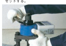
⑤メガネレンチでナットを締めながらアンカーに引張力を加えて測定する。
