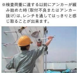
※検査荷重に達する以前にアンカーが緩み始めた時(取付不良またはアンカー抜け)は、レンチを通してはつきりと感じることが出来ます。
