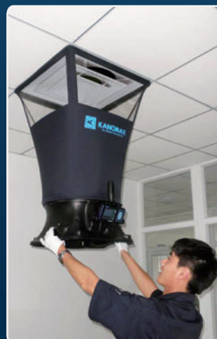
空調機器の点検・調整に
