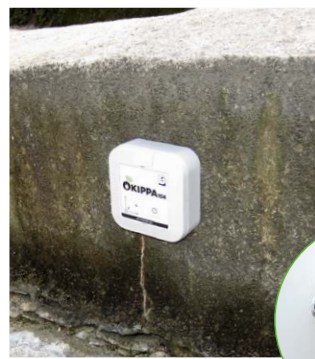
コンクリート部に設置 (アンカー利用)
