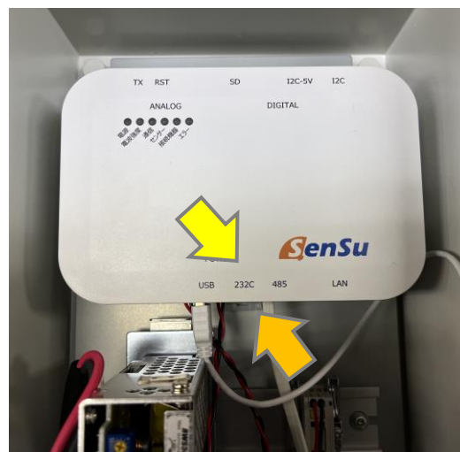
【写真 5-2 本体設置後】
