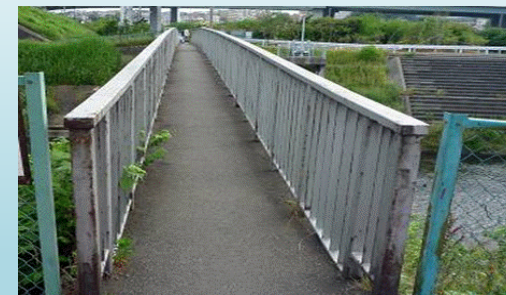
橋梁点検車が入れない
