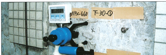
(外壁補修用アンカーピン引張強度測定)
