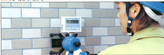
(外装タイル接着強度測定)
