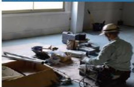
通電前の内装工事
