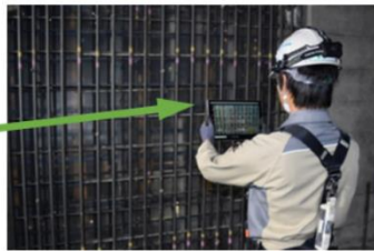
【デプスカメラ搭載タブレットでの計測作業】
