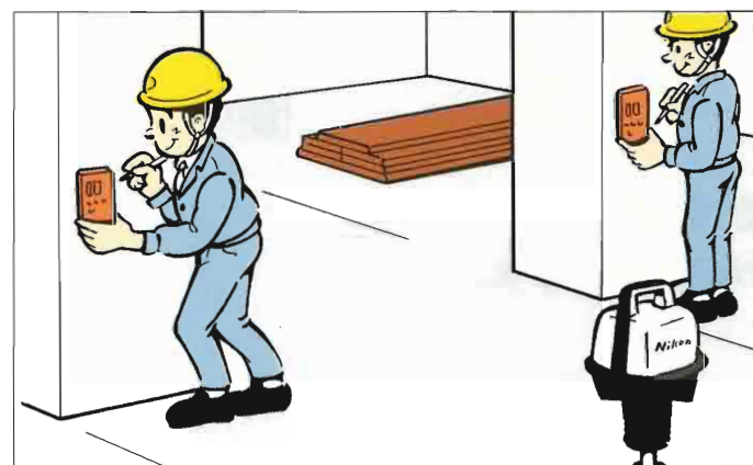
建築仕上り工事の墨出し
