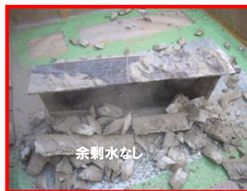
鉄骨除去状況（湿式） 余剰水なし
