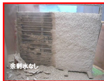
リブラス壁除去状況（湿式） 余剰水なし
