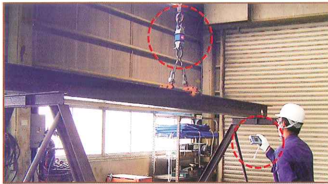
●鋼材の吊上げ機の安全管理
