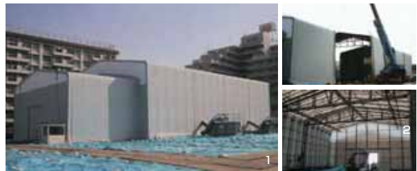
1 W19.5m × H8.5m 前室付タイプ 外観 2 100t レッカーによる移設 3 W19.5m × H8.5m 内観
