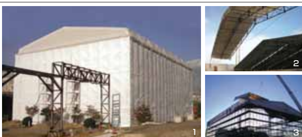
1 焼却炉解体用仮囲いテント 外観 2 施工状況 3 施工状況
