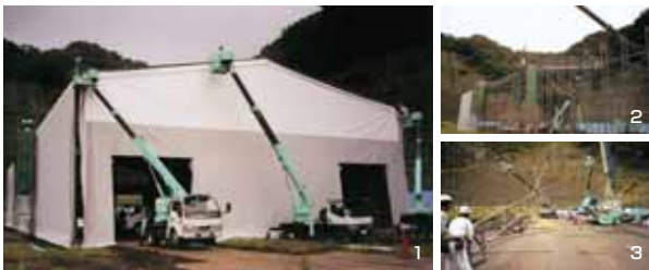
1 妻面テント取付 2 本体テント取付 3 鉄骨建方
