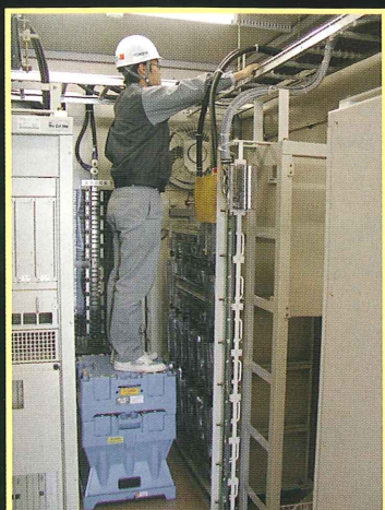
電気・通信工事
