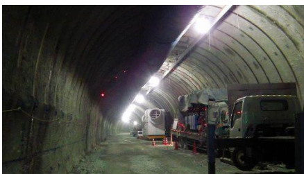
トンネル現場 ミストファンによる 粉塵対策、2次覆工加湿養生
